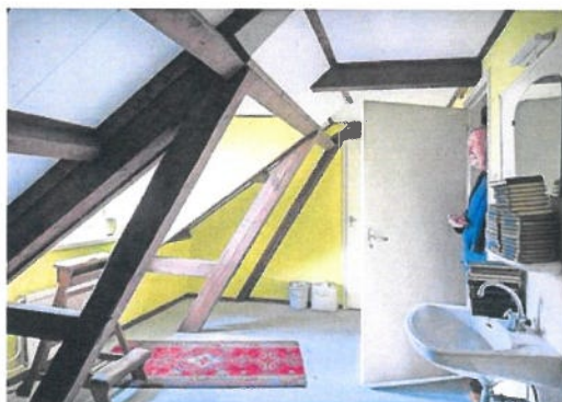
Bovenste verdieping met verlaagd plafond.
